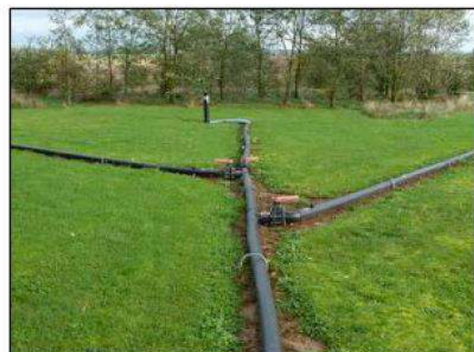
Photo 8 : Illustrations - Puit de captage de biogaz (à gauche), Réseau de captage sur site réaménagé (à droite) (Photo Séché Eco-services)
