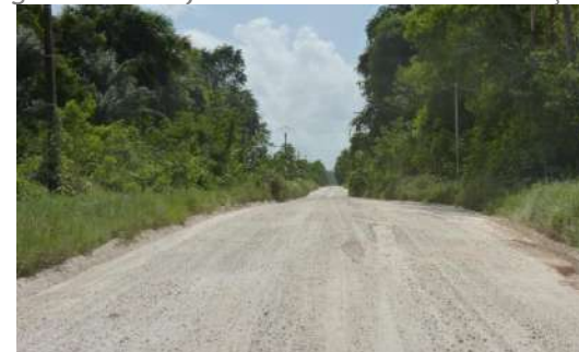
Figure 5: Elargissement de la piste sur la droite
