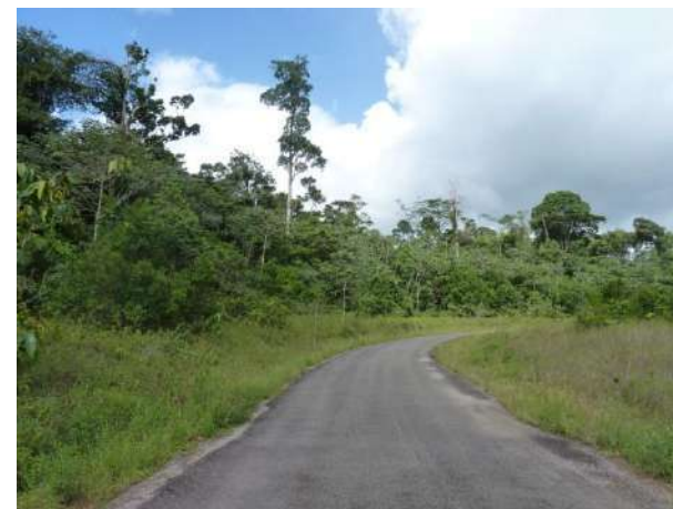
Figure 37: Début du tronçon 11
