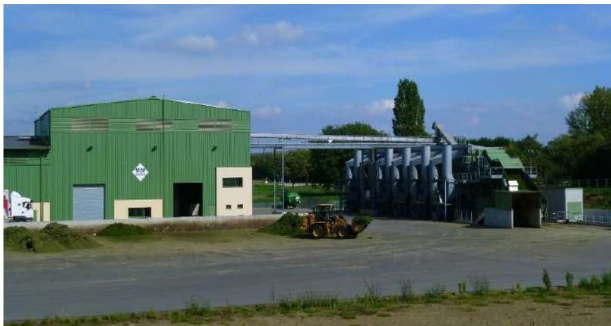
Photo 9 : Infrastructure de déshydratation de fourrages de DESHYOUEST
