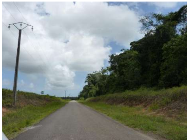
Figure 57: Début du tronçon 13
