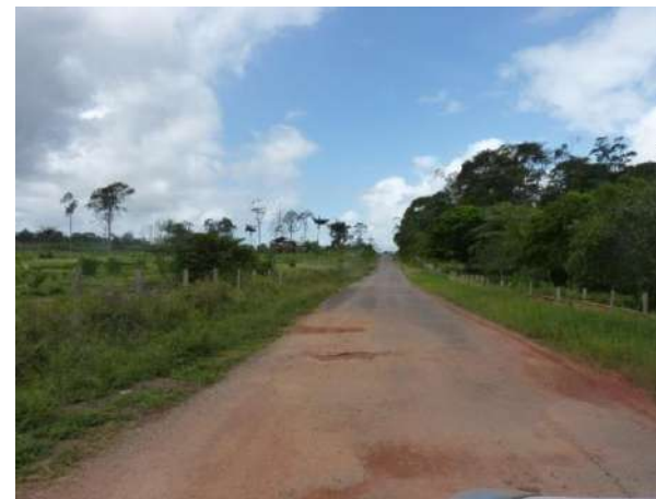
Figure 35: Début du tronçon 10
