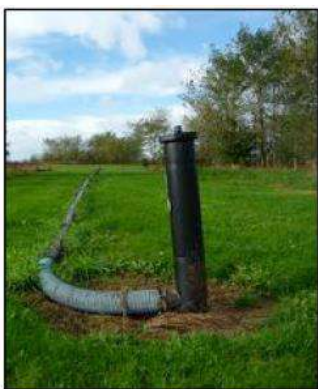
Photo 8 : Illustrations - Puit de captage de biogaz (à gauche), Réseau de captage sur site réaménagé (à droite) (Photo Séché Eco-services)
