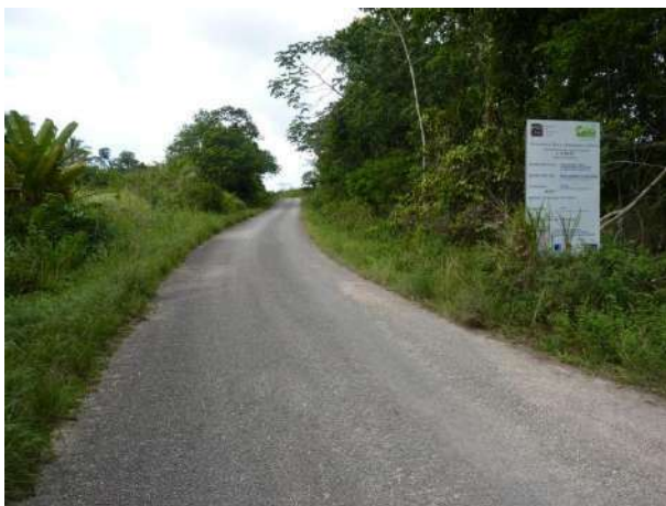
Figure 21: Début du tronçon 7
