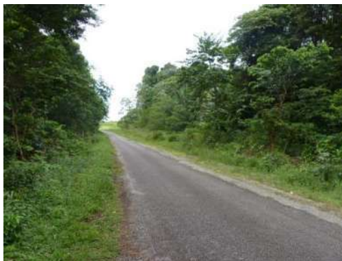
Figure 33: Début du tronçon 9
