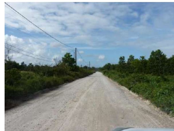
Figure 11: Début du tronçon 4
