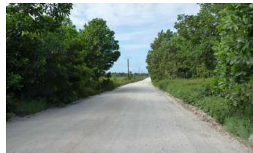
Figure 7: Début du tronçon 3
