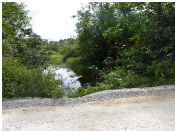
Figure 16: Crique au niveau du passage busé
