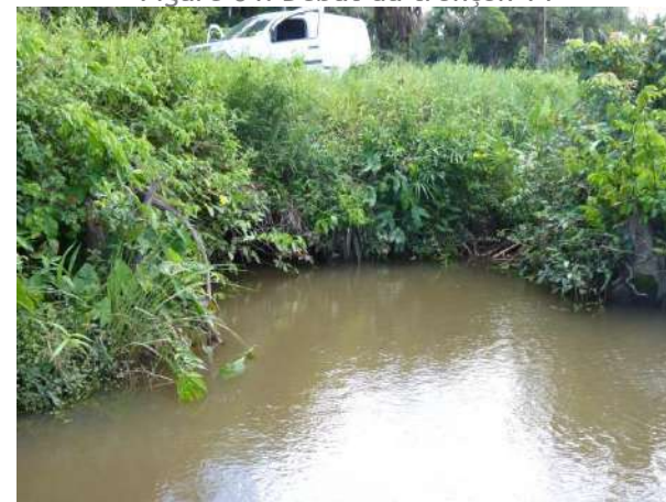
Figure 65: Passage busé, buse non visible (crique de part et d'autre de la voie)
