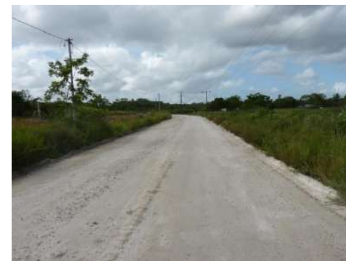
Figure 14: Début du tronçon 5
