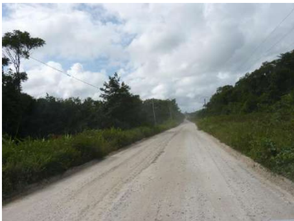
Figure 15: Début du tronçon 6
