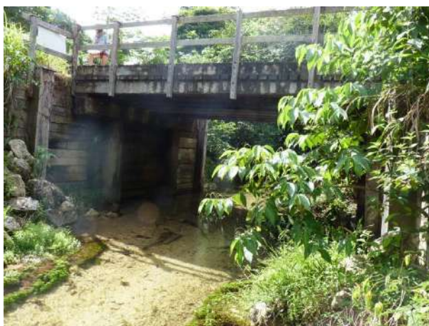
Figure 31: Pont, vue de dessous
