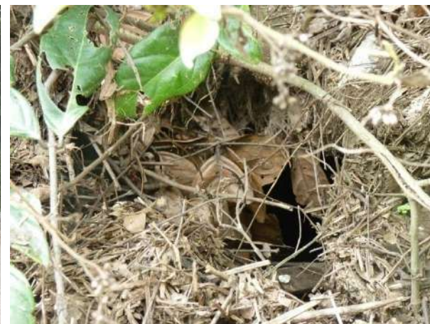
Figure 17: Passage busé (côté gauche)
