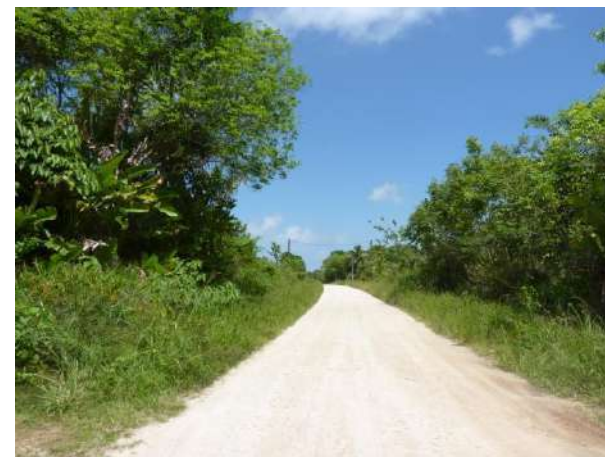
Figure 64: Début du tronçon 14
