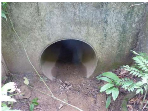
Figure 42: Buse (diamètre 800 mm)
