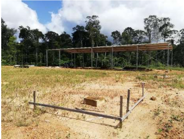
Photo 7 : Hangars aménagés et fondations prévues pour un 2 ème hangars (source : Solicaz)
